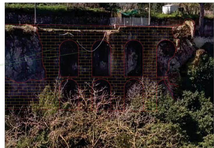
struttura a piloni ed archi in ca. rivestita con muratura in tufo a faccia vista
