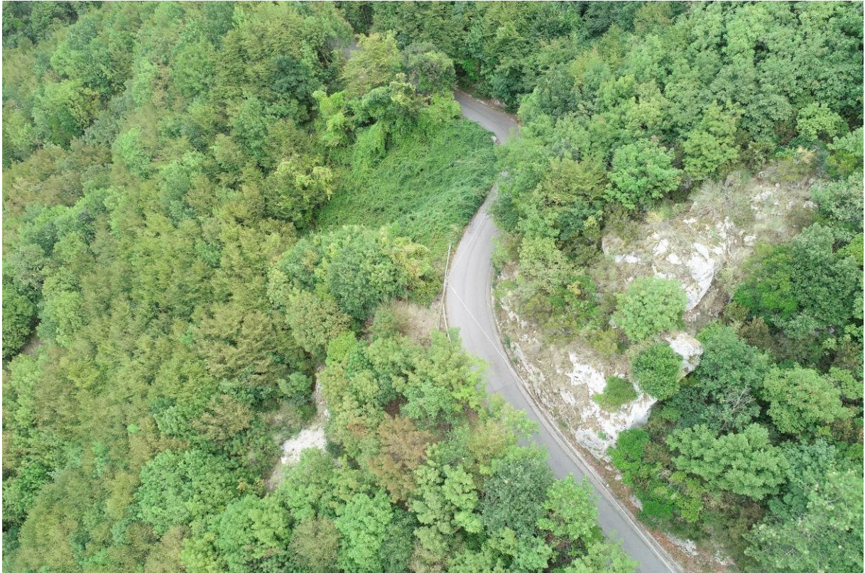
Foto 2 – area da sottoporre ad intervento mediante rafforzamento corticale e rete
