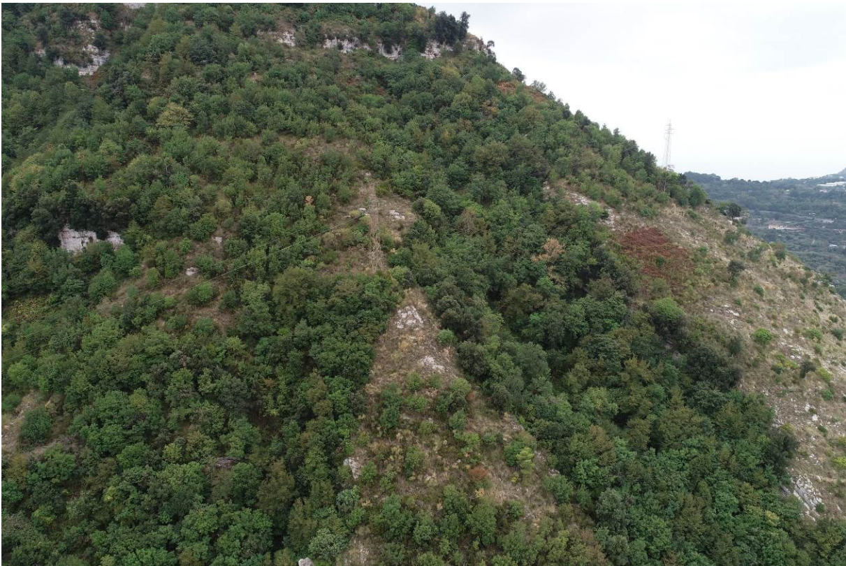
Foto 3 – area interessata dalla installazione di barriere paramassi
