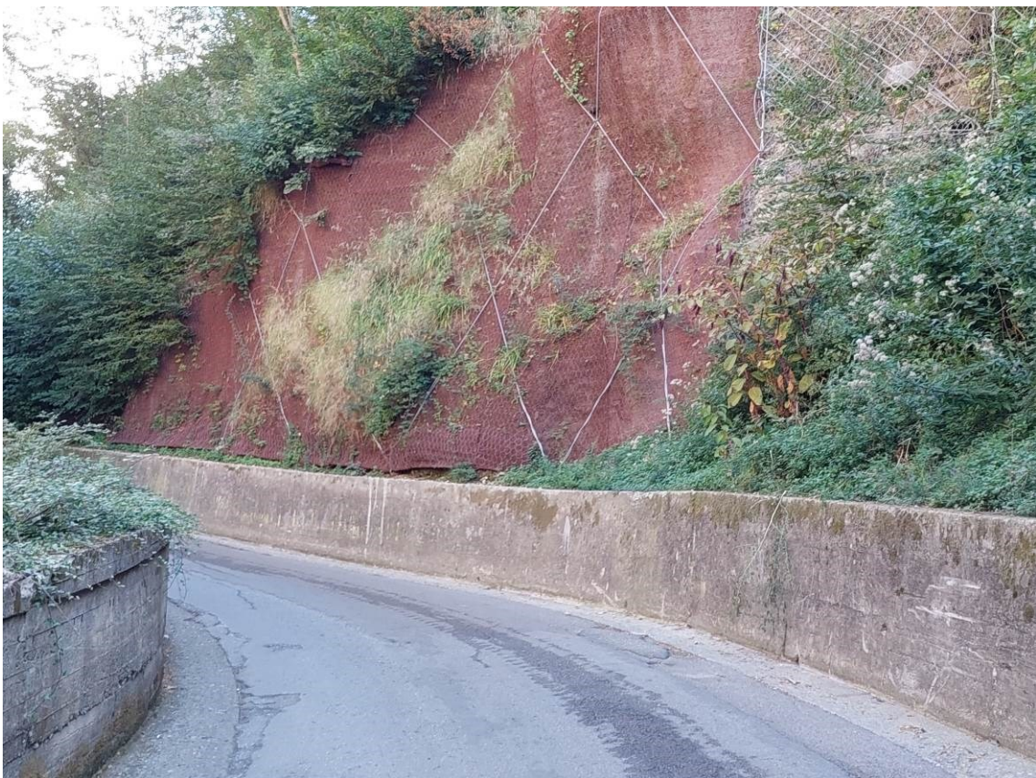
Foto –intervento di messa in sicurezza con rete e geo stuoia precedentemente realizzato
