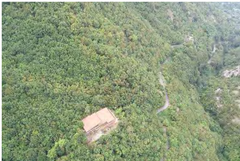
Fig. 2.2 Vista dall'alto del tratto di Via Lavinola oggetto di interventi di mitigazione del rischio
