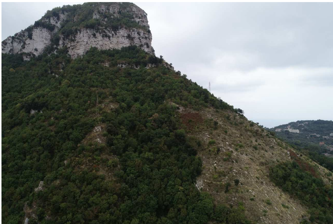
Foto 1 e 2 Versante monte Vico Alvano interessato dagli interventi.
