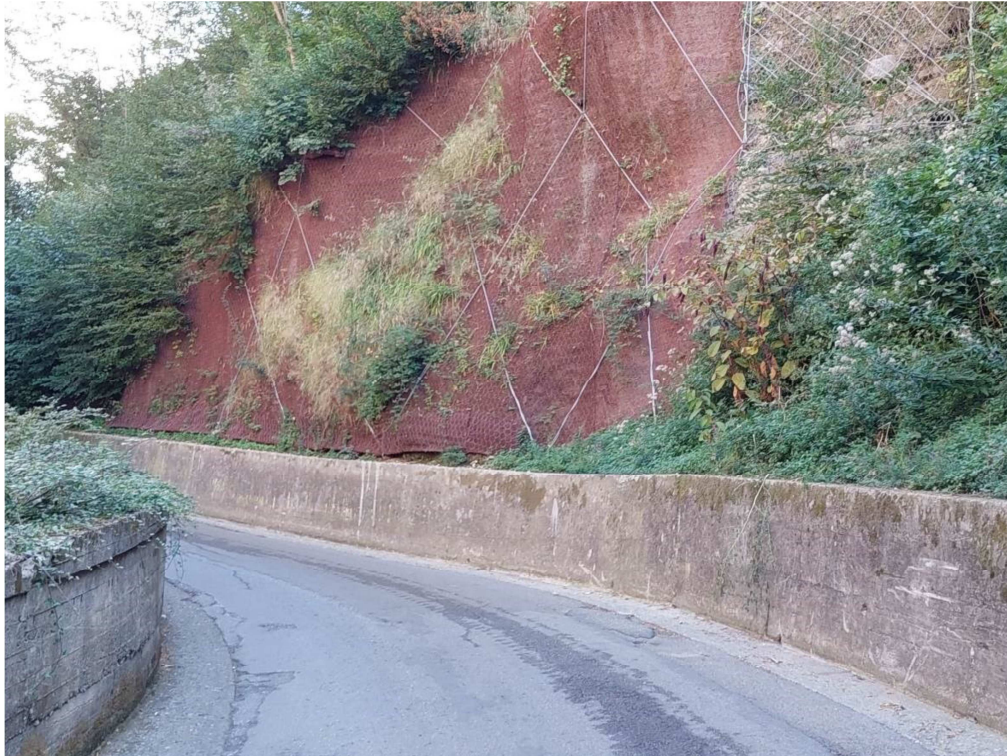
Foto 4 Intervento con rete e geostuoia precedentemente realizzato in via Lavinola.
